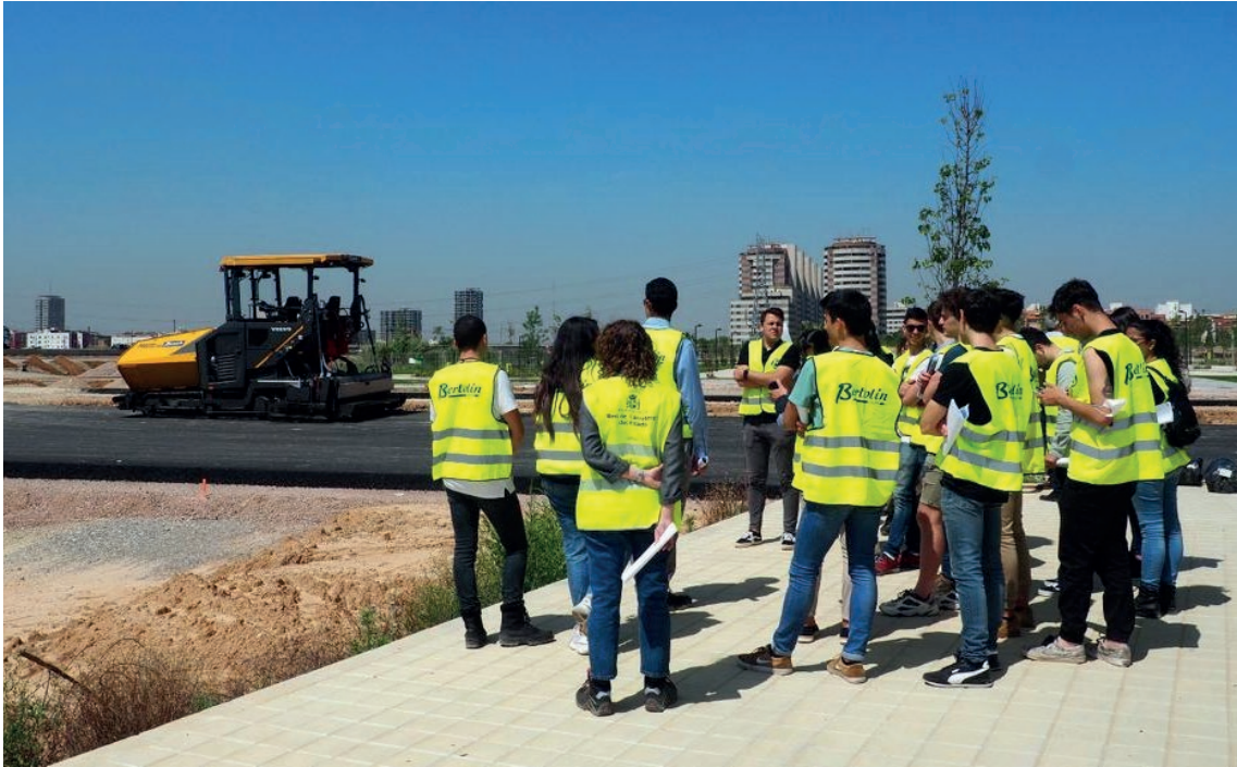
Visita estudiantes de 2º de grado a las obras de accesos al nuevo barrio de Turianova. Cátedra Bertolín.
