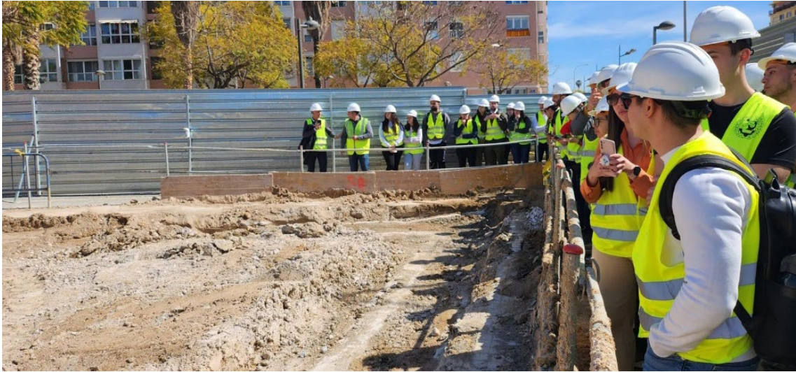
Visita obras de Edificio en Avda. Taronjers (Edifesa).
