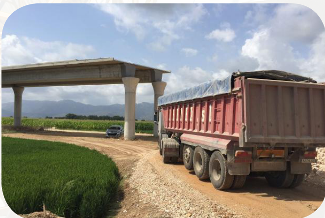
Obras en el tramo A-38.
