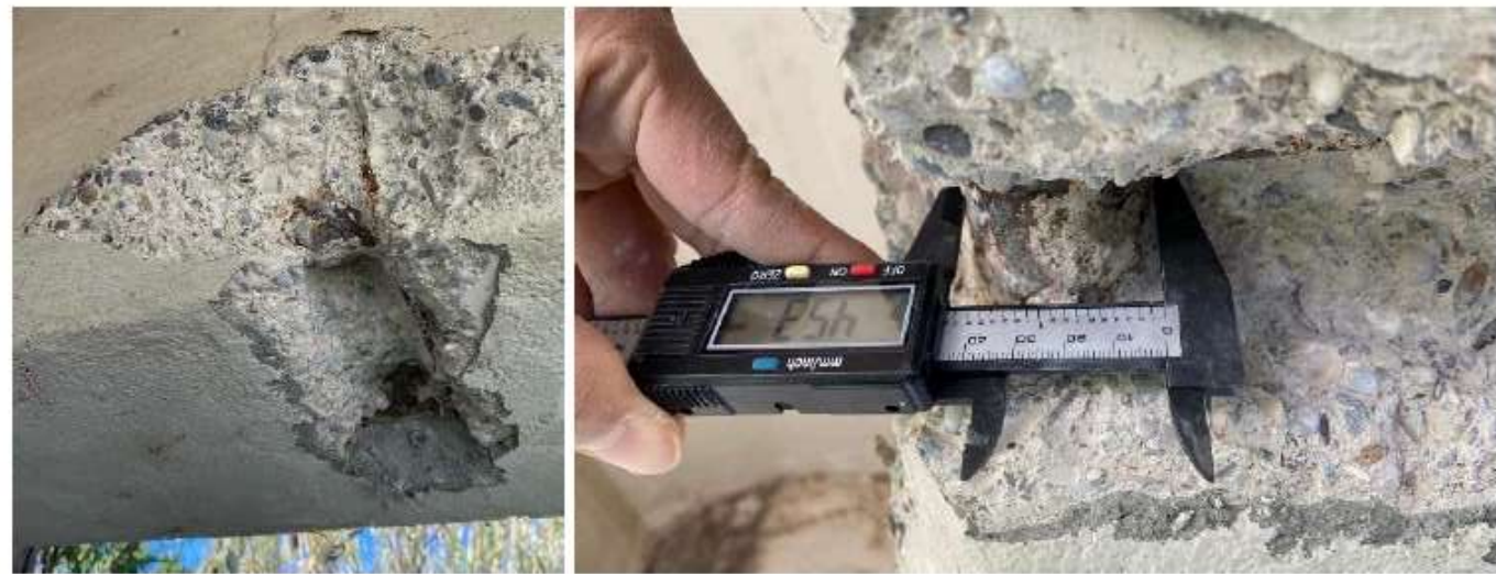
Imagen 12. Catas realizadas por la AT (fuente: Calsens).
