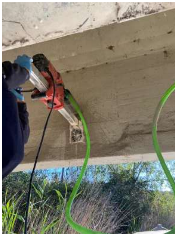
Imagen 11. Extracción de testigos (fuente: Calsens).
