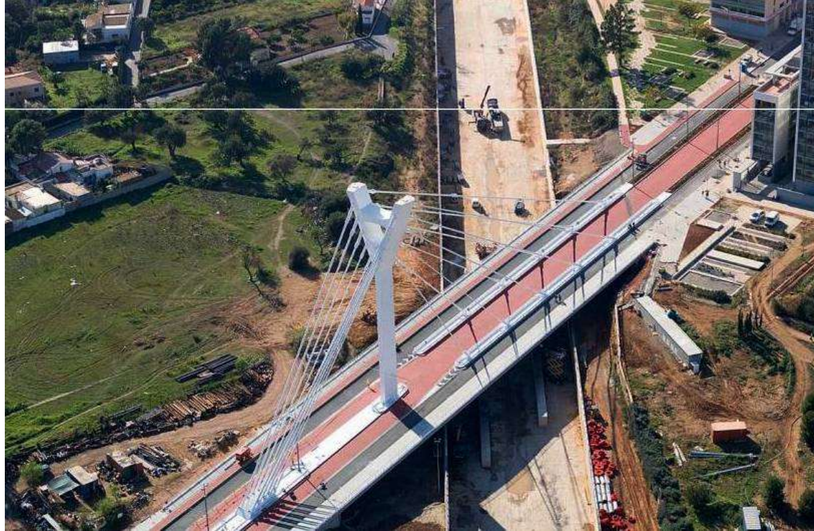
Imagen 8: Puente atirantado en Castellón. Fuente: Cazando puentes
