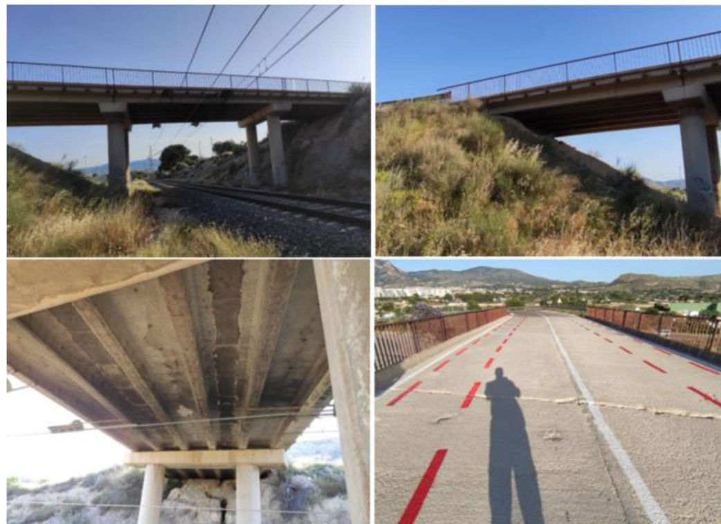
Imagen 4: Puente de vigas prefabricadas sobre la línea 330 en el PK: 416+200. Fuente: Proyecto original
