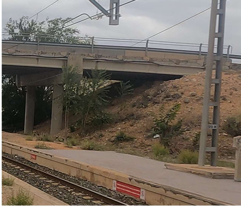
Imagen 11: Estribo abierto sobre la traza de la vía de proyecto. Fuente: Elaboración propia
