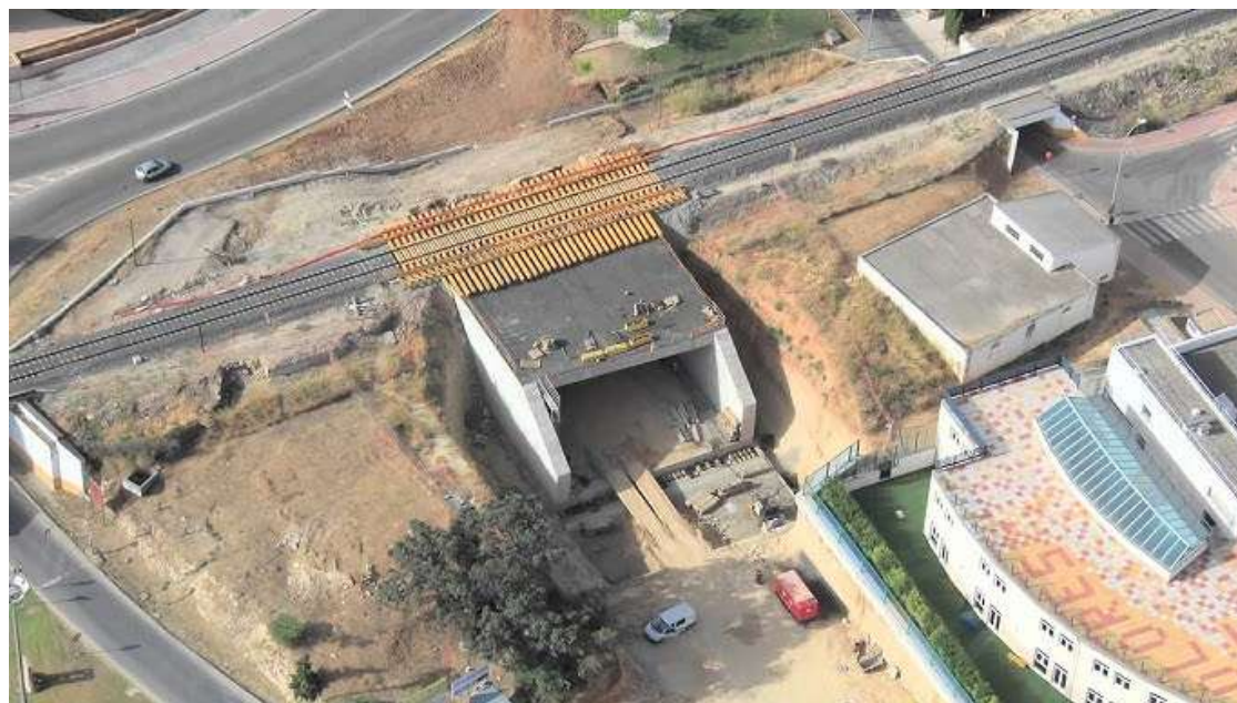
Imagen 2: Paso inferior en cajón por empuje bajo ferrocarril ejecutado por OPEMA Fuente: Empuje de cajones y apeo de vía, OPEMA.
