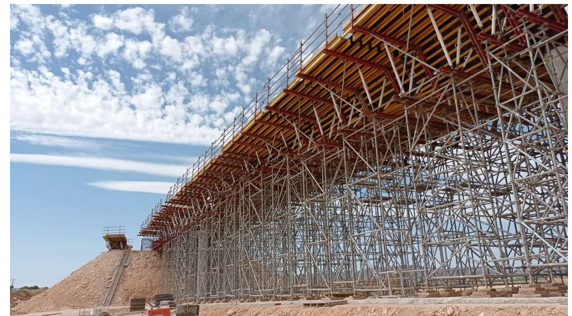
Imagen 6: Puente de hormigón "in-situ" con cimbras. Fuente: Encofrados Alsina
