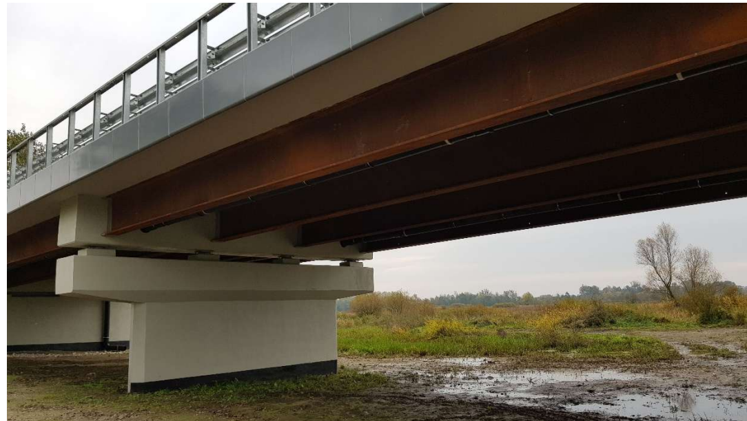
Imagen 5: Puente mixto hormigón - acero. Fuente: Constructalia – AcelorMittal
