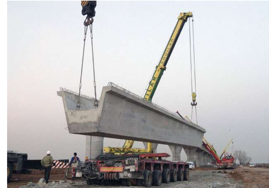
Imagen 13: Viga prefabricada en sección artesa. Fuente: El blog de Víctor Yepes
