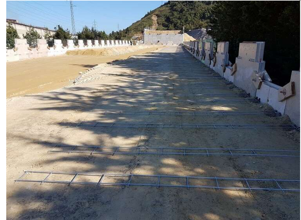
Imagen 14: Flejes de tierra armada. Fuente: edtf.es
