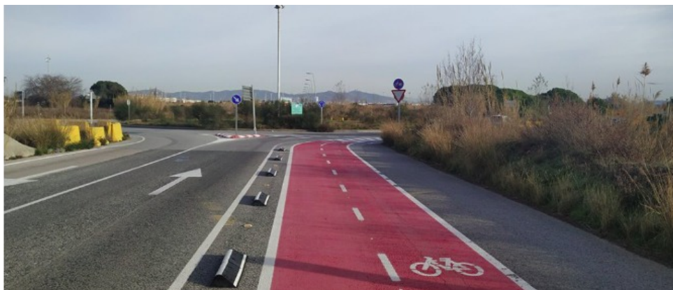
Figura 40: Carril bici bidireccional en un margen de la carretera. Fuente: Elaboración propia
