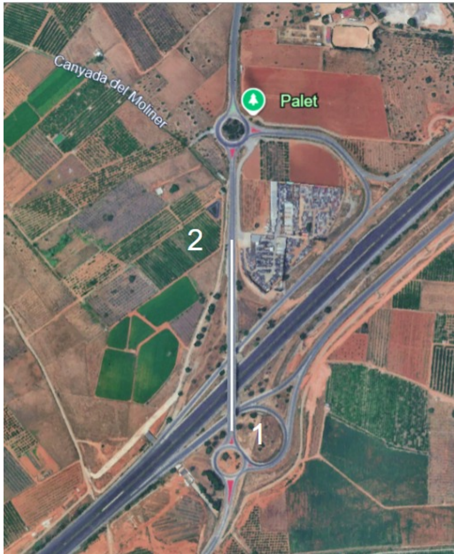
Figura 7: Zona de continuidad de distribución de carriles (Margen izquierdo paso superior-Zona desguace). Fuente: Google Earth
