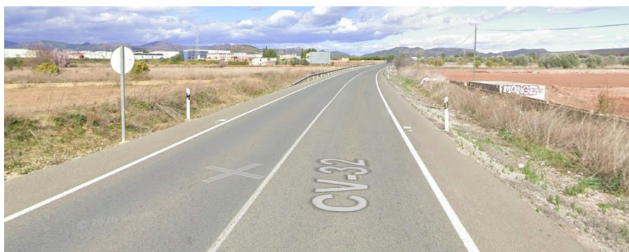
Figura 36: Carril actual en la CV-32. Fuente: Google maps
