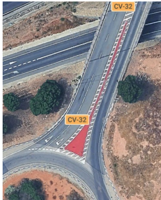
Figura 3: Zona 2 de pérdida de arcén. Fuente: Elaboración propia
