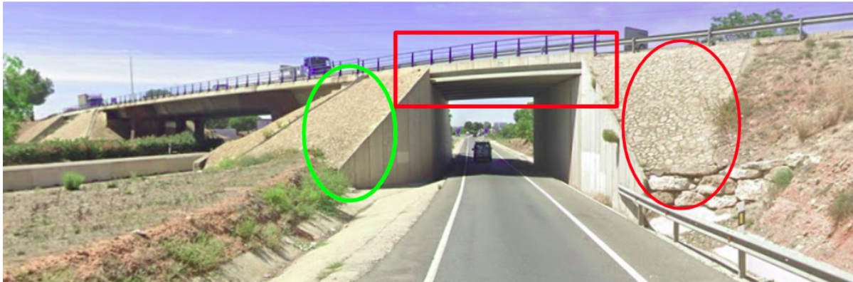
Figura 22: Estribos y tablero a demoler (en rojo) de la CV-32S. Fuente: Google Maps
