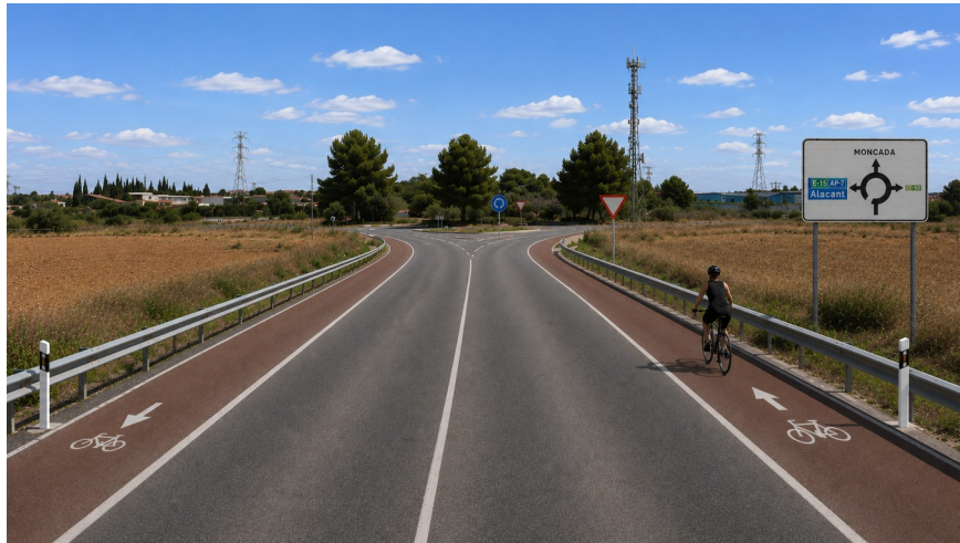
Figura 39: Carriles bici unidireccionales en ambos márgenes de la carretera. Fuente: Elaboración propia
