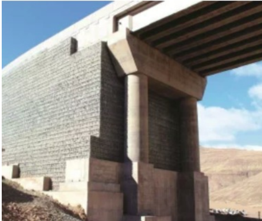
Figura 31: Fustes de las pilas y dintel hormigonados. Fuente: Freyssinet
