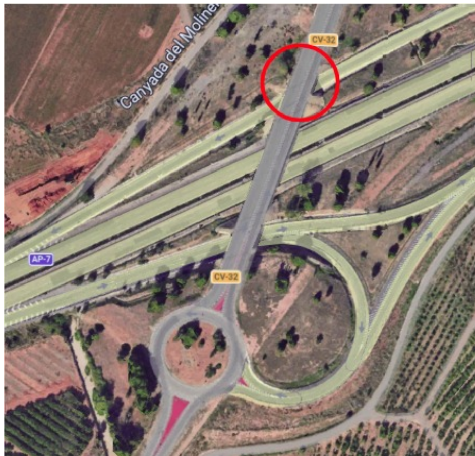
Figura 6: Margen derecho del paso superior de estudio. Fuente: Google Earth
