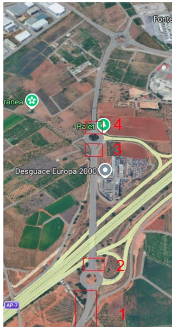
Figura 13: Zonas con pérdida de arcén. Fuente: Elaboración propia
