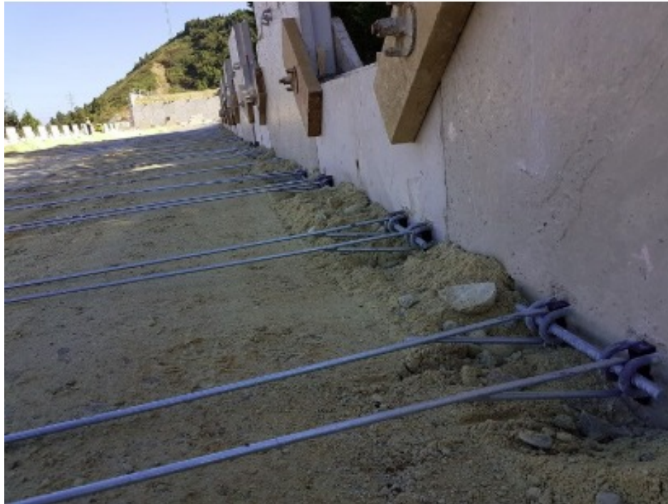
Figura 30: Ejemplo de una capa del muro de tierra armada. Fuente: deconstrucción
