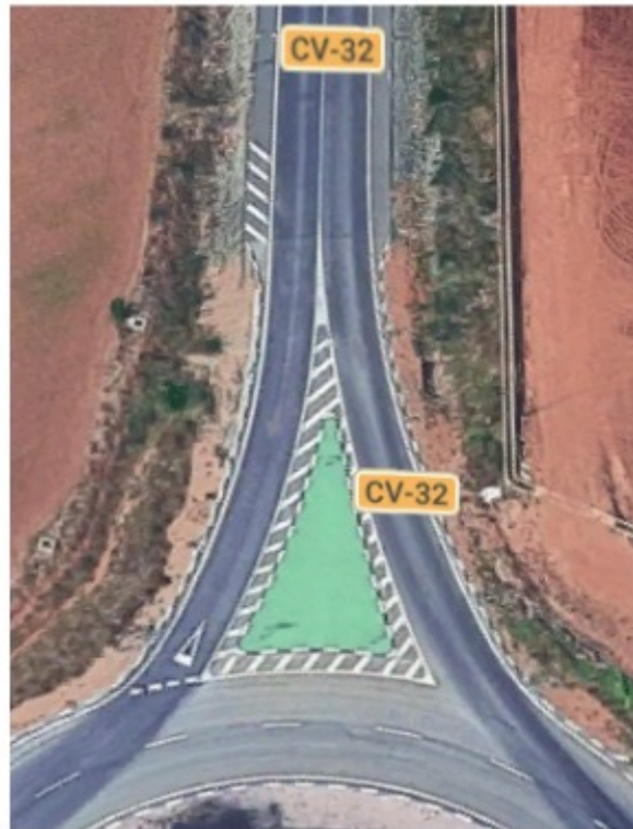
Figura 5: Zona 4 de pérdida de arcén. Fuente: Elaboración propia
