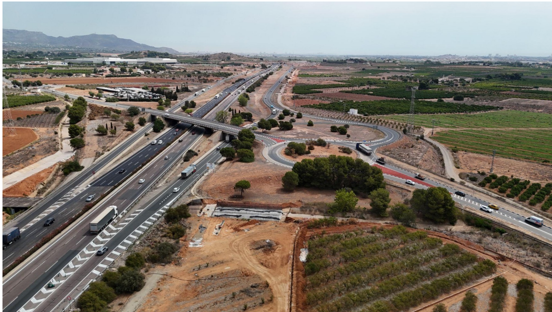
Figura 2: Vista aérea del paso superior de la CV-32S. Fuente: Proyecto adjudicado
