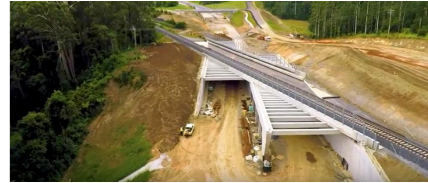
Figura 5. Puente pérgola sobre la autovía del pacífico, Australia (Fuente. O'Neill, 2019).
