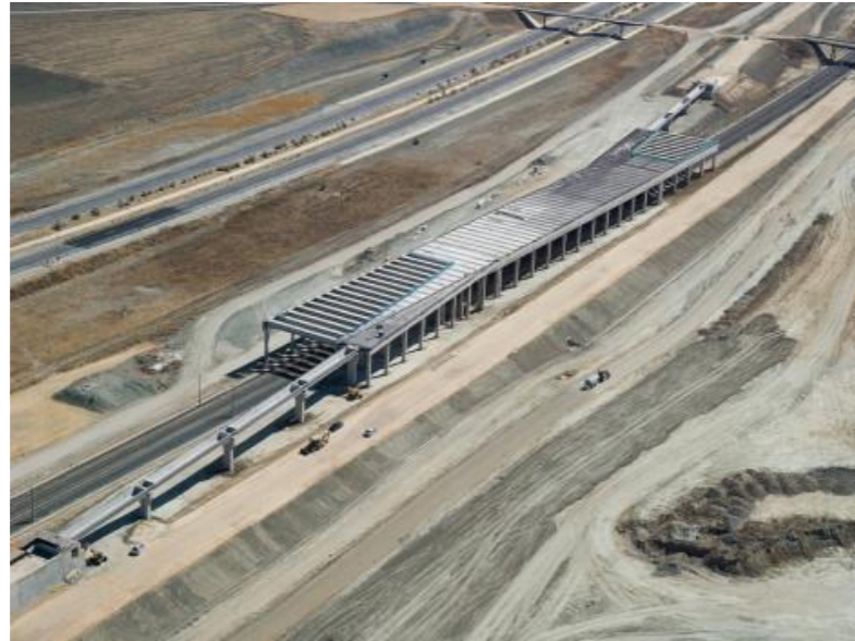
Figura 3. Puente pérgola en emplazamiento de estudio, cruce LAV Madrid-Levante sobre línea FFCC Madrid Sevilla, en Pinto (Madrid). (Fuente. CONSTRUBLOG, 2014).
