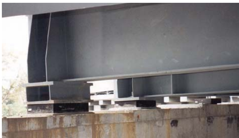
Fig. 14 – Edificio sobre apoyos elastoméricos
