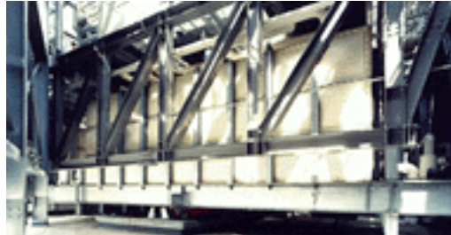
Fig. 20 – Contenedores de agua utilizados como amortiguadores en la Crystal Tower (Japón)
